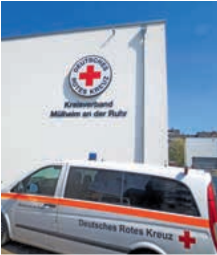
Im Dunkeln erstrahlt das DRK-Logo in LED-Beleuchtung. Im Hintergrund die Fahrzeughalle.
